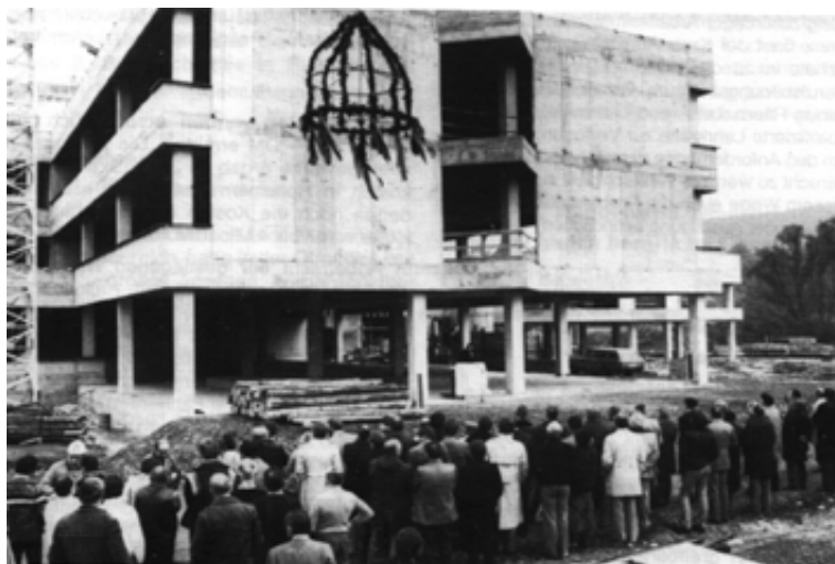
Beim Richtfest des neuen Berufsbildungszentrums Foto: Kreisbildstelle
